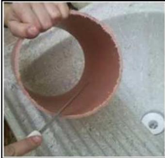
do arco de serra e depois lixá-lo para deixar as bordas lisas. Para isso, utilize uma lixa ou a faca. Em seguida, coloque o cano dentro da gaiola maior através do orifício da tela afixada no lugar da porta ou no lugar onde foram cortadas as grades da gaiola. Pode-se utilizar uma das luvas de PVC para uma melhor fixação do cano. Então, conecte esta luva no lugar que ficaria o cano e conecte o cano na luva pela
